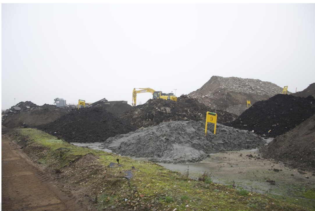
Foto: Mogelijke inspectielocatie voor geo-elektrische meting.
