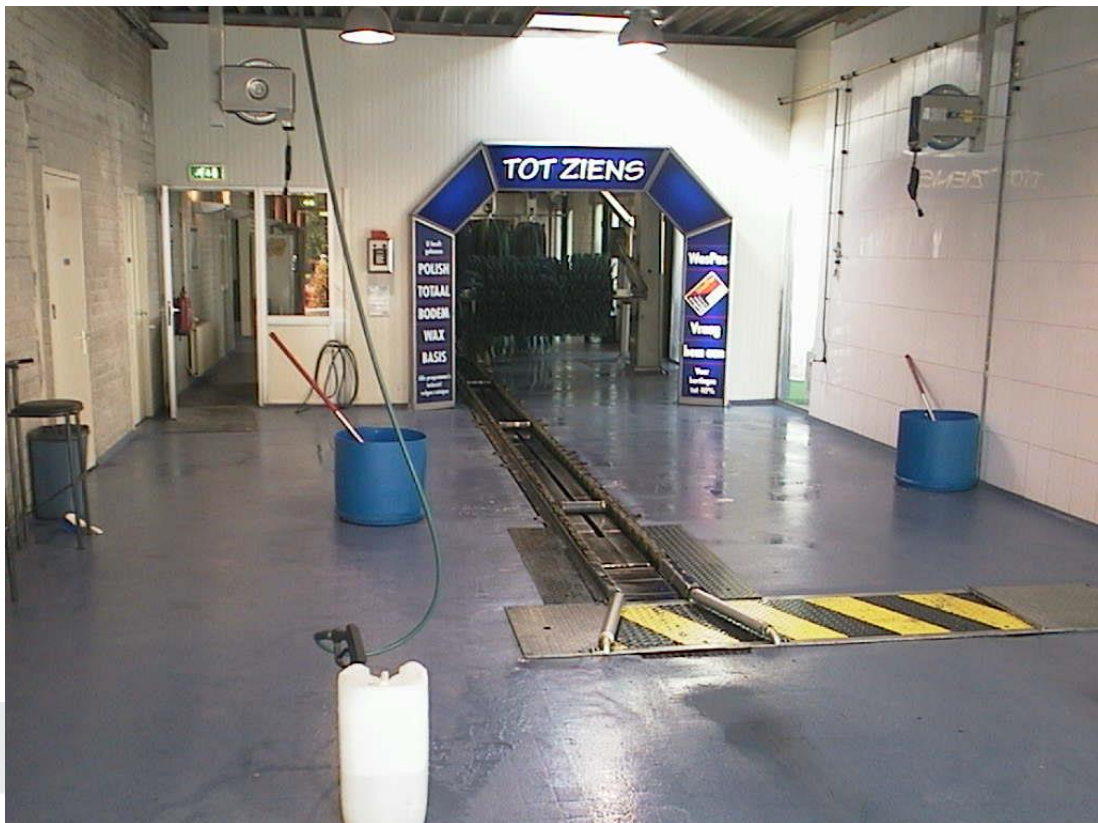
Foto: Voorbeeld te inspecteren vloeistofdichte voorziening.
